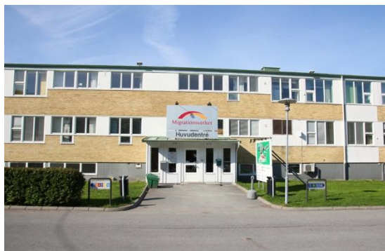
Om- och tillbyggnad Livedred 1:329
