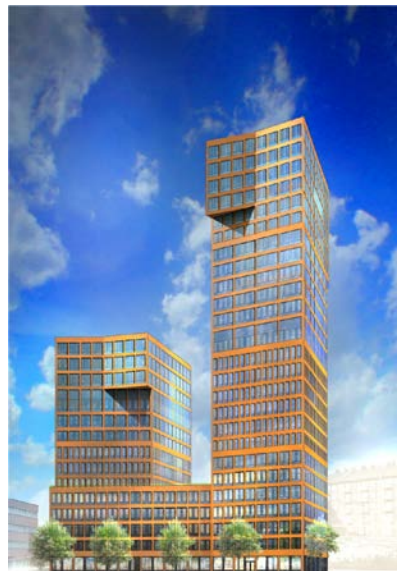
Nybyggnation Gårda 2:12, 15-25 000 m 2
